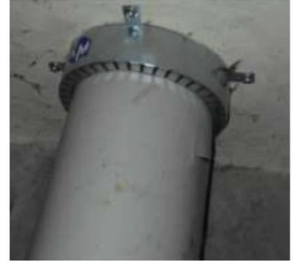
**CARATTERISTICHE.:** KM-FS è un collare di tenuta al fuoco, costituito da un guscio aperto in acciaio zincato contenente strisce di materiale intumescente a base grafitica ad alta espansione termica **KM-FF107**.
